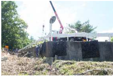
7区車道擁壁工事
