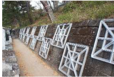
西7区擁壁工事
